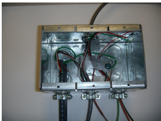
图3-4 嵌入式安装的大致管路和电气连接
